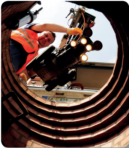
Überprüfungsarbeiten mit Hilfe eines Roboters
