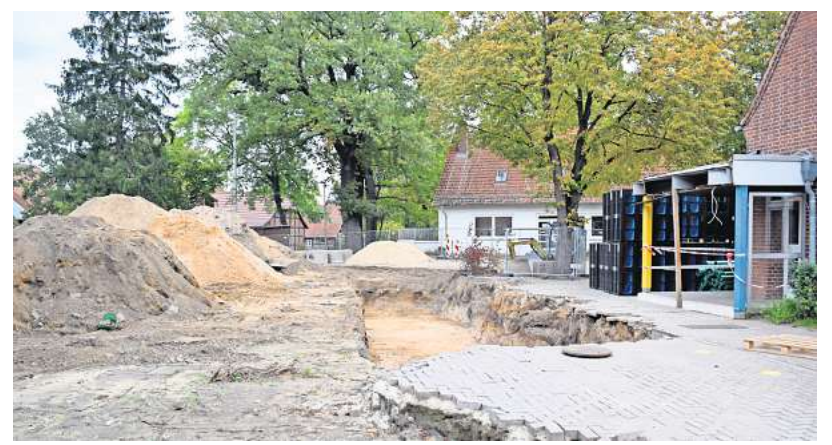
Noch Baustelle: Der Schulhof der Grundschule Stelingen wird derzeit umgestaltet.
