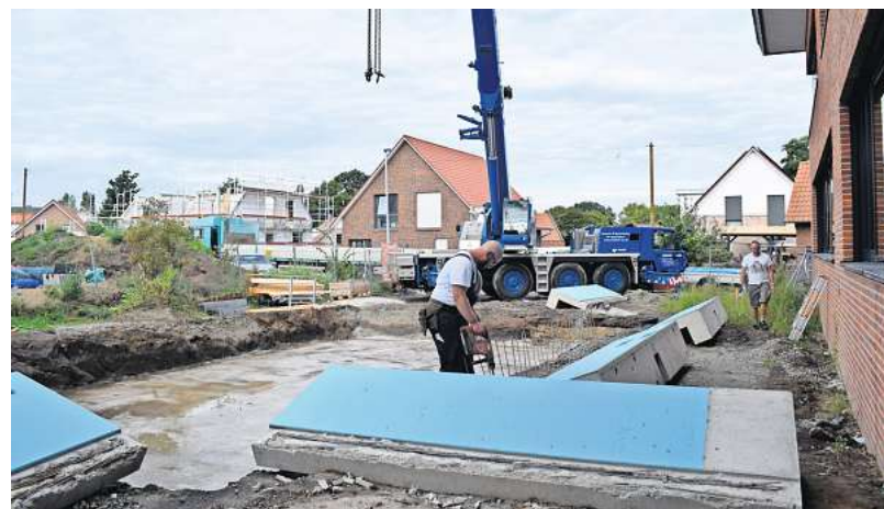
Auch die Arbeiten am neuen Lehrschwimmbecken haben begonnen.
