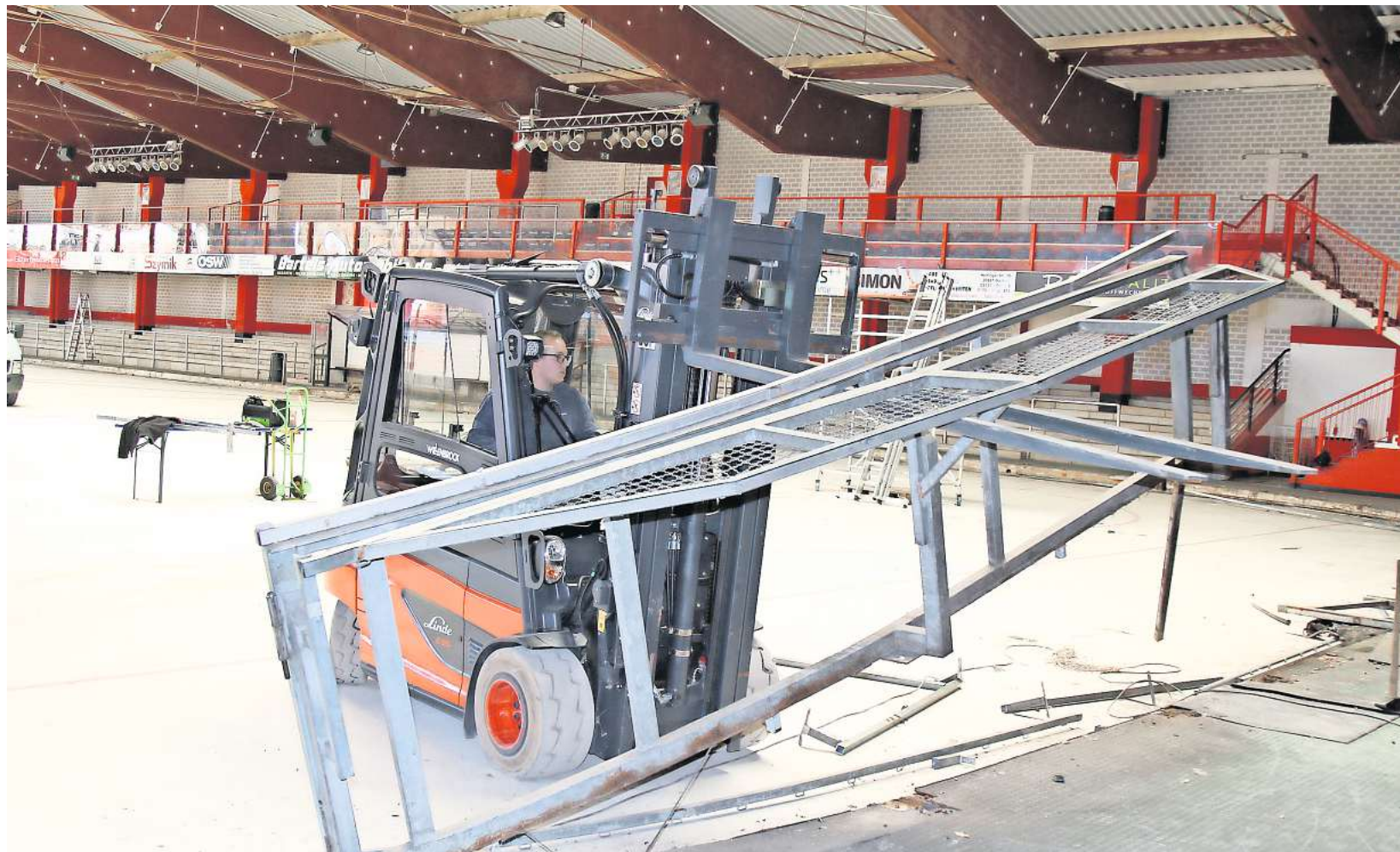
Runderneuerung: Nach Dach und Fotovoltaikanlage ist nun die Bande im Eisstadion Mellendorf an der Reihe.
