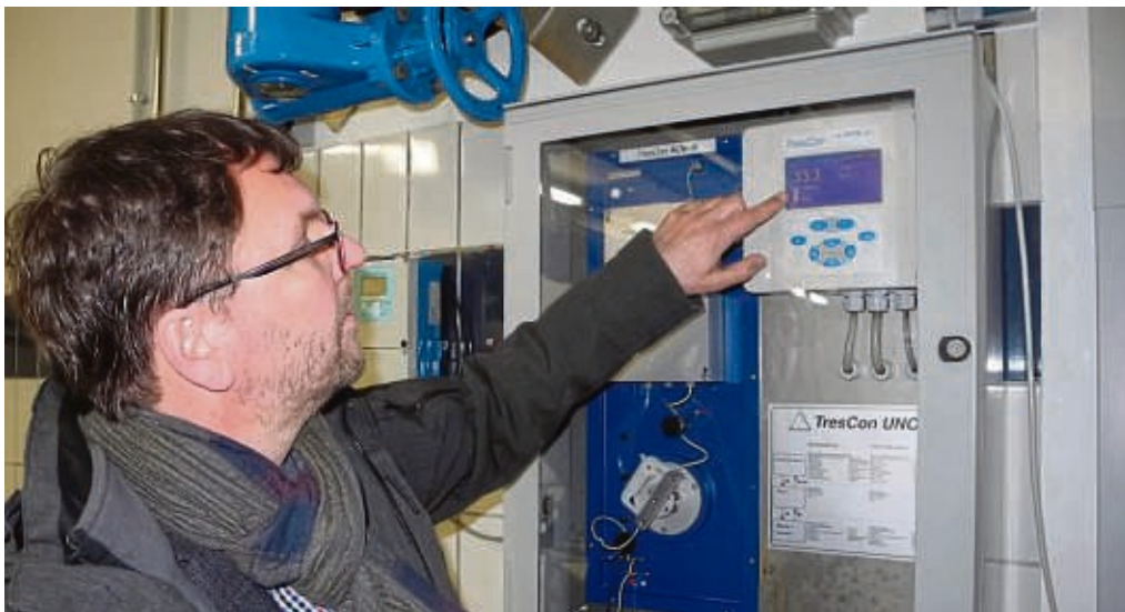
Geschäftsführer Stephan Schumüller liest am Nitratmessgerät einen aktuellen Wert von 33,3 Milligramm pro Liter ab.
