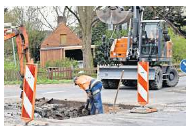
Der Wasserverband lässt ein Schieberkreuz austauschen.
