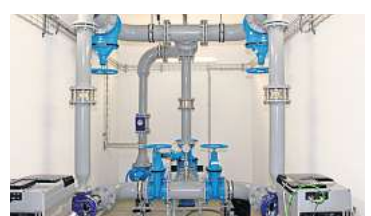
Blick in die Druckerhöhungstation. FOTO: WVGN
