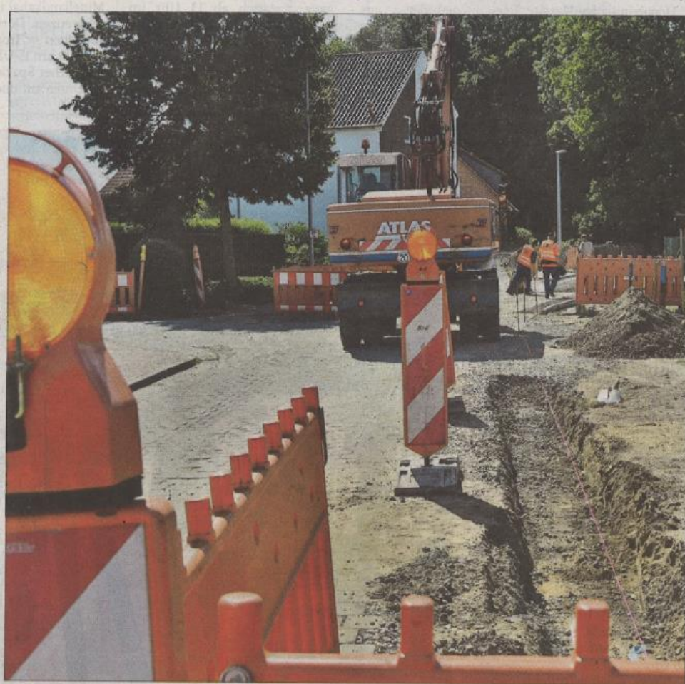
Die Sanierung der Trinkwasserrohre in der Seebeeke ist beendet. Jetzt muss der Straßenbelag neu aufgebracht werden.
