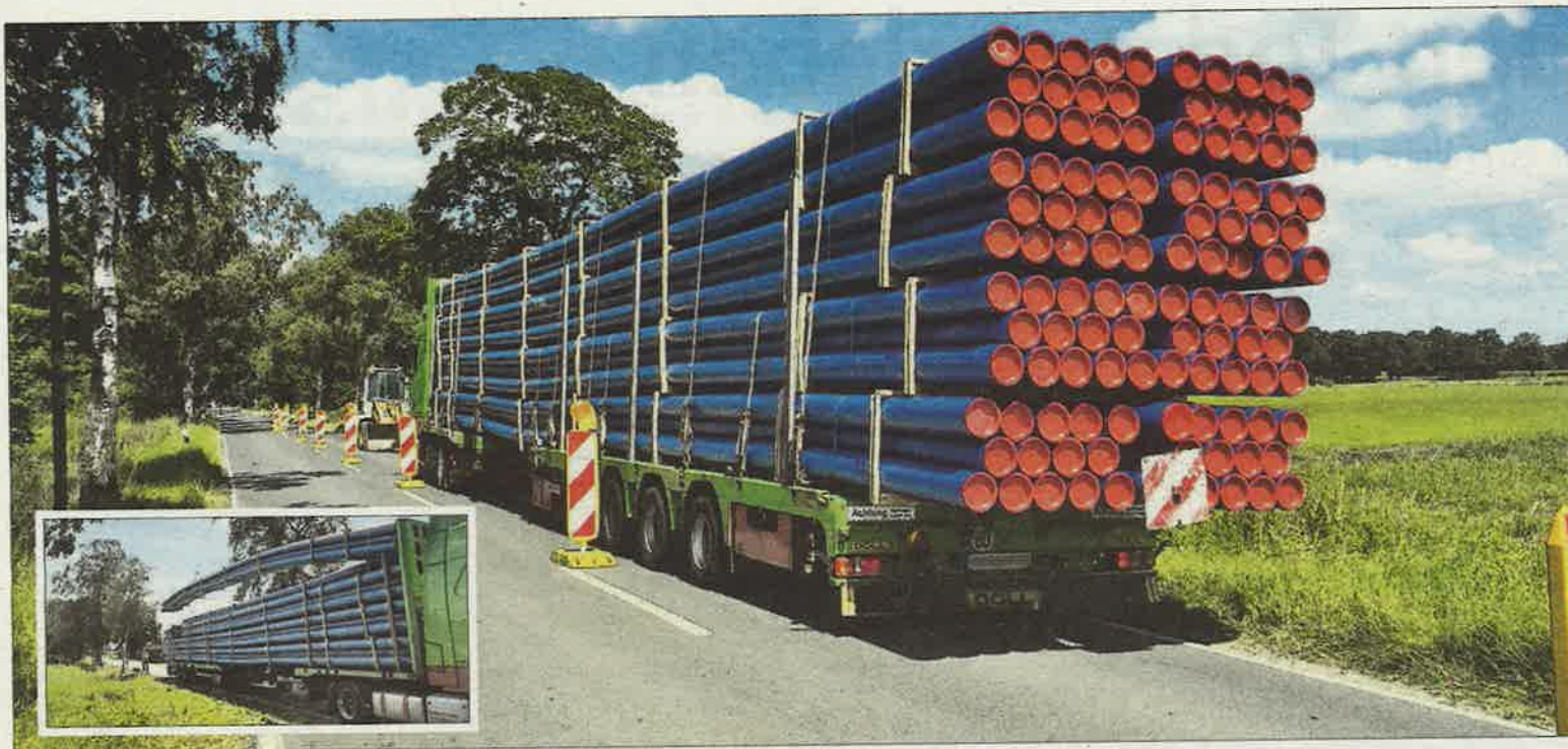
Die Rohre sind da: Der Wasserverband verlegt zwischen Heitlingen und Resse eine neue Trinkwasserleitung. Wasserverband Garbsen-Neustadt (2)
