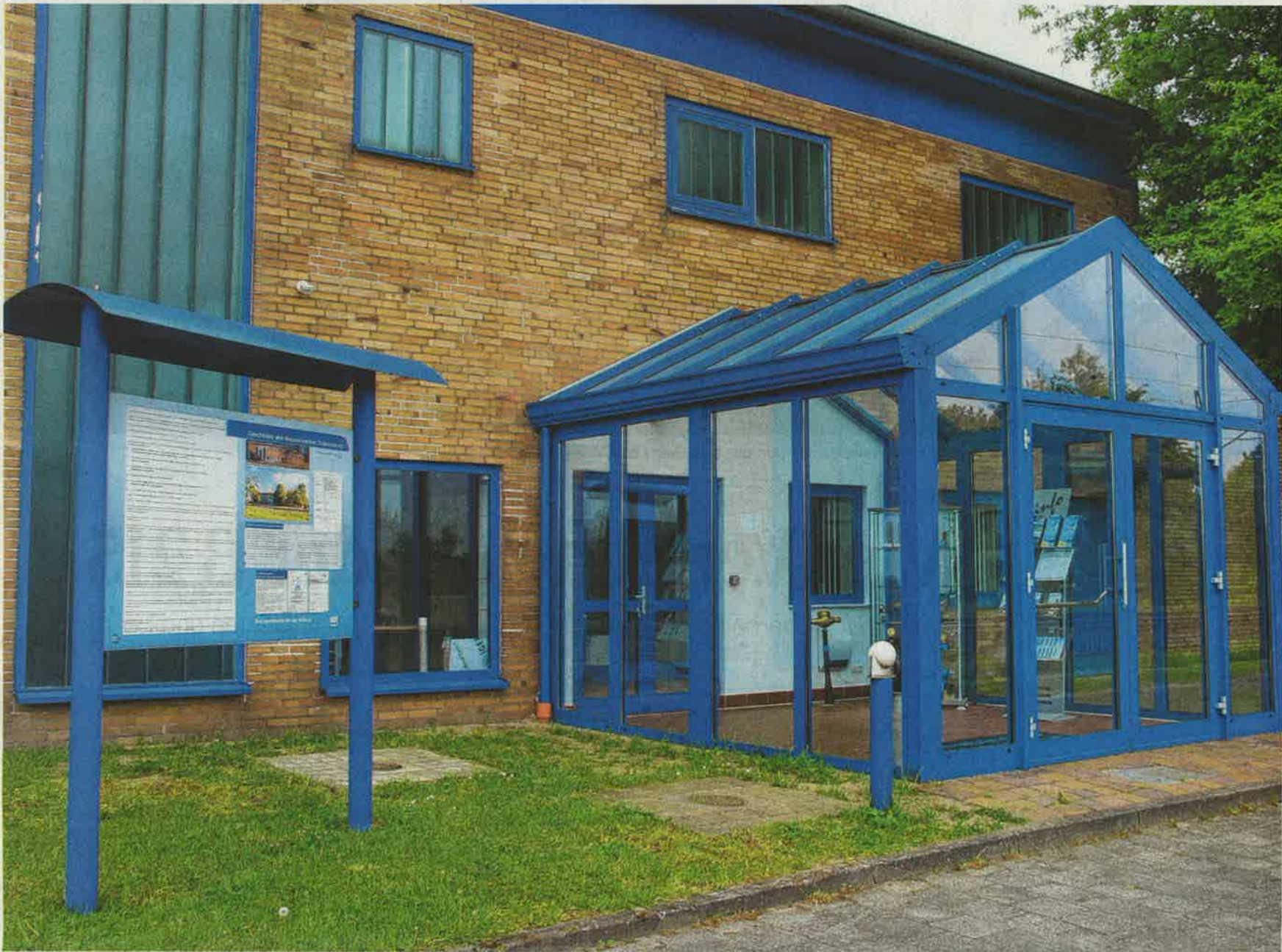
Wenn es nach den Forderungen der von Lochfraß Betroffenen geht, soll das Drakenburger Wasserwerk zumindest vorübergehend vom Netz genommen werden. Laut Tim Hauschildt ist ein Wasserwechsel allerdings auch kein Allheilmittel.
