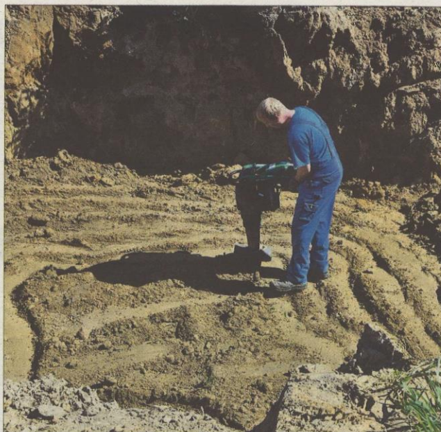
Der Boden wird verdichtet, damit später keine Kuhlen entstehen. Rocktäschel
