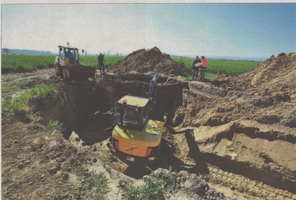
Zum Schutz des Grundwassers: Ein Schaufelbagger verteilt Ton in der Findling-Grube bei Ostermunzel.
