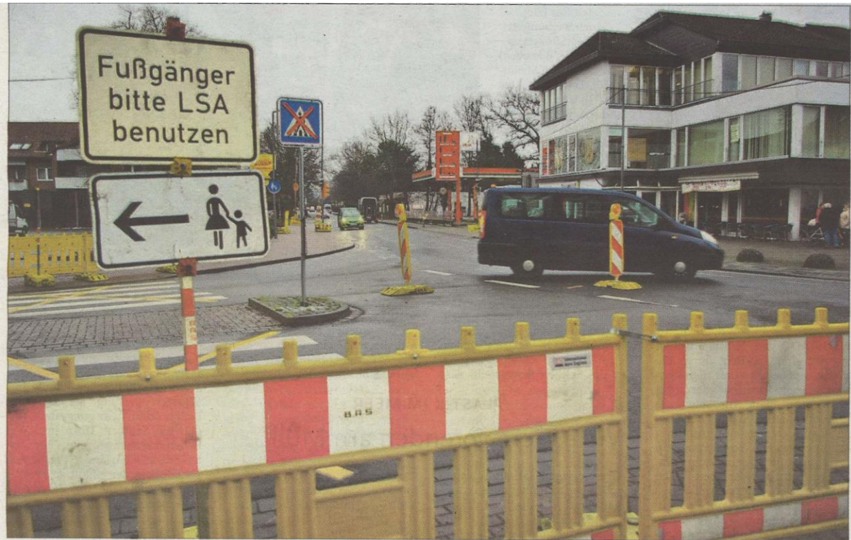
Autos werden mit einer Ampelanlage um den Engpass am Birkenweg/Ecke Osterwalder Straße herumgeführt.
