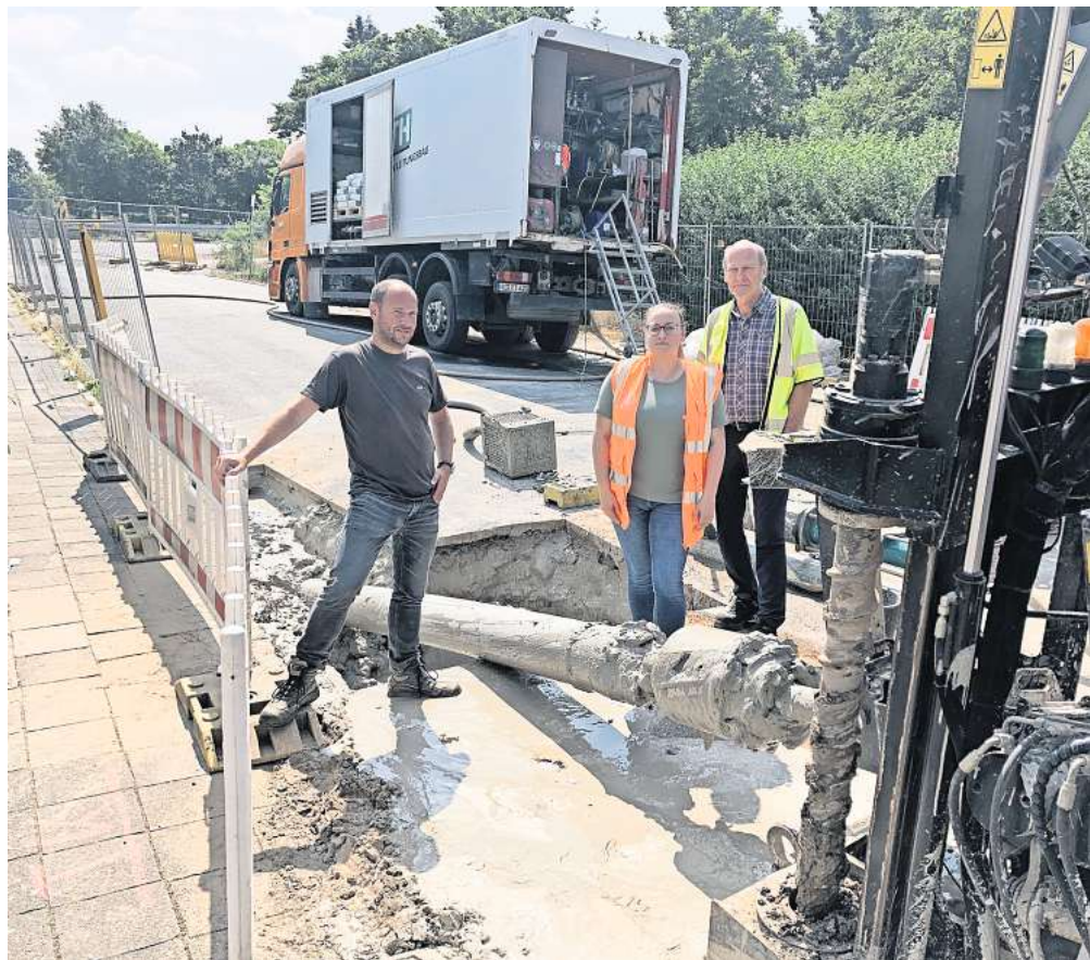
Von hier aus fließt es unten durch: Christian Hübner, Mareike Duschek und Reinhard Ideker an der Bohrgrube in Altgarbsen, über die Leitungen für Wasser, Gas und Strom unterhalb des Mittellandkanals bis Havelse verlegt werden. FOTO: SIMON POLREICH
