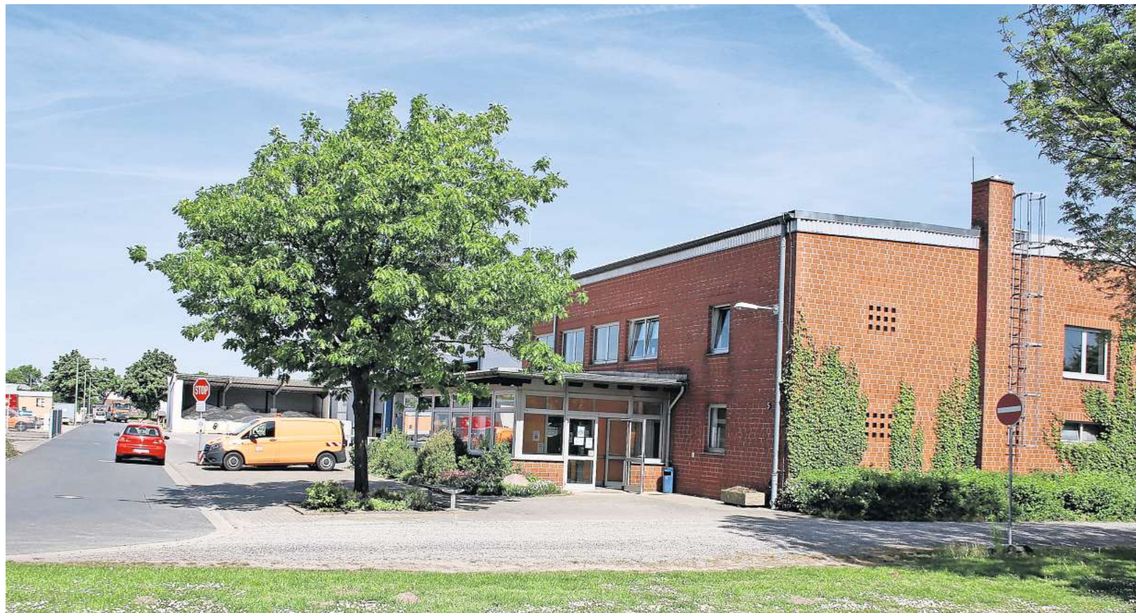
Erweiterung: Das Verwaltungsgebäude des Baubetriebshofs soll künftig mehr Platz bieten.
