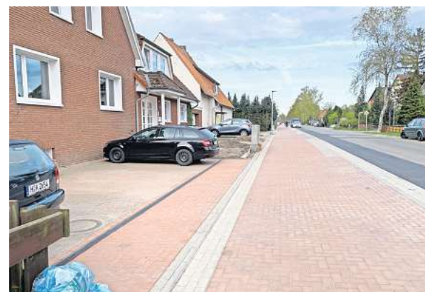
Abschüssig: Die Stadt hat selbst auf Grundstücken neue Entwässerungsrinnen einbauen lassen.
