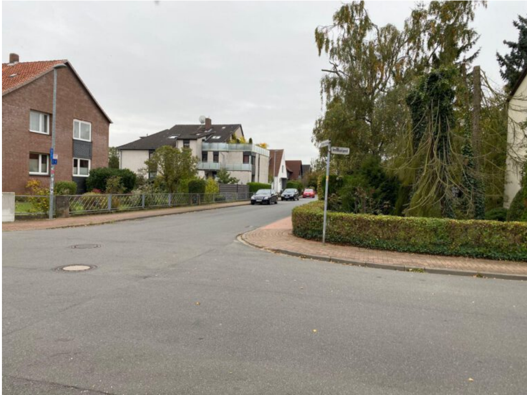
Hier finden die Arbeiten statt/GCN
